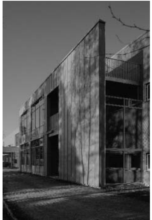
Südfassade /South façade
